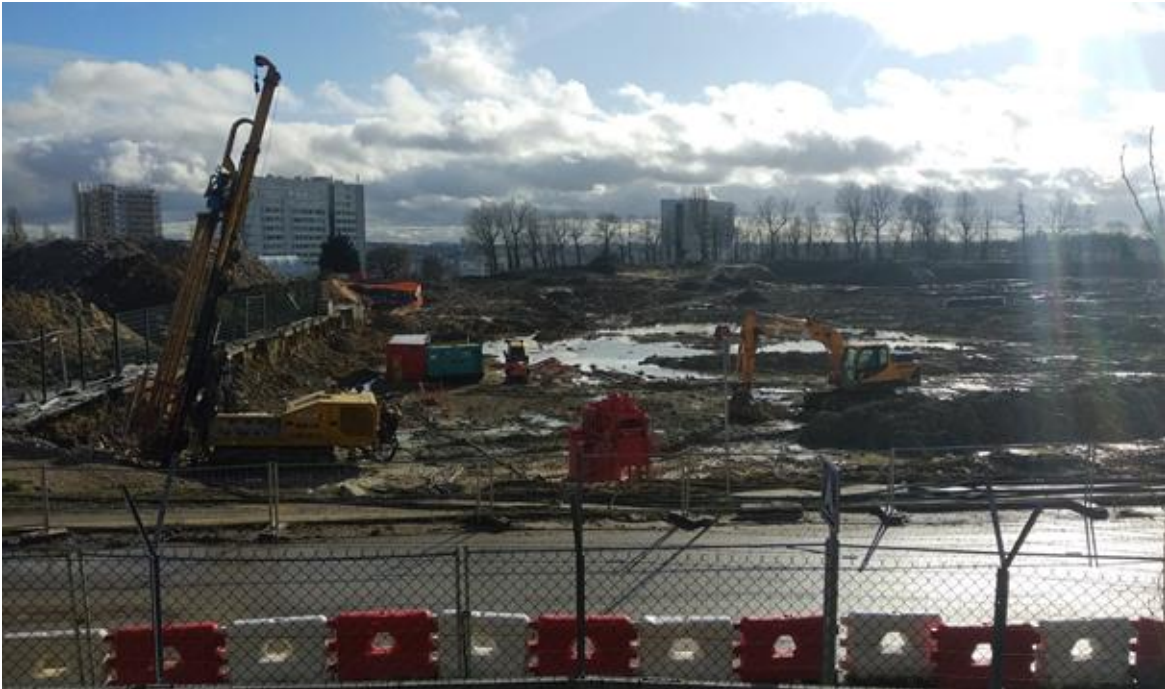
Figure 10. Dépollution et mise à niveau des sols dans le site des Mathurins (Bagneux)
