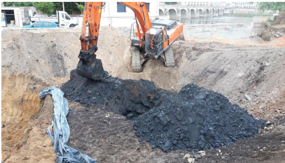
Figure 7. Photographie de dépollution dans un projet d'aménagement et régénération urbaine sur des fonciers pollués d'anciennes usines de gaz d'Engie, réalisé par Brownfields.
